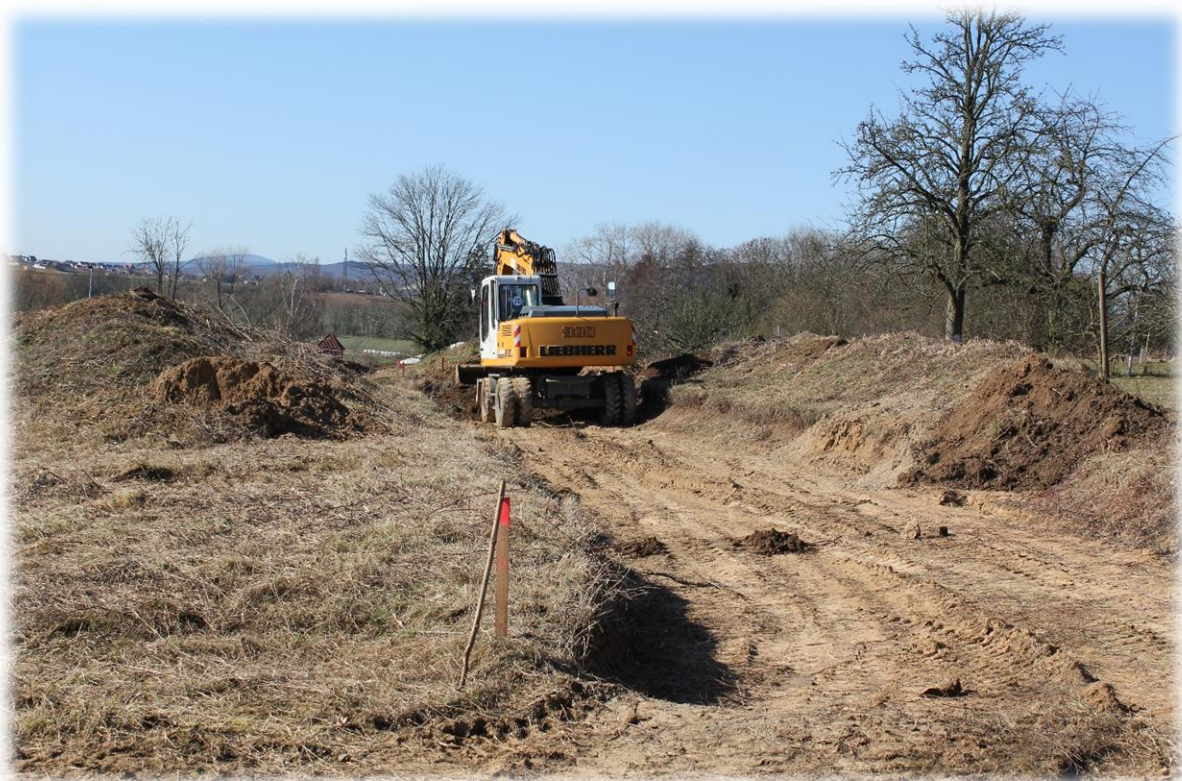
Diese Umgehungsstraße wird in ein Streuobstgebiet hineingebaut
